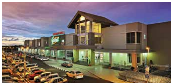
Naim Permy Mall @ Naim Bandar Baru Permyjaya, Miri
