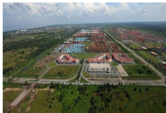
On-going project - Bandar Baru Permyjaya
